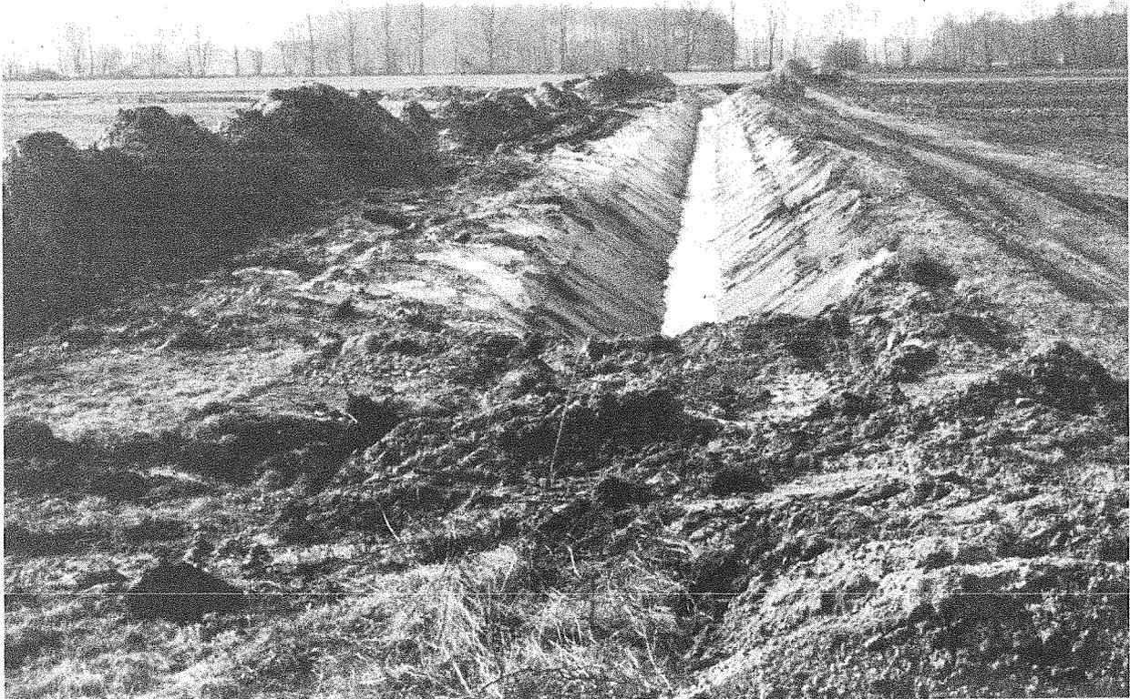
Abb. 31: März 1985 - Binnenentwässerung im Bereich südlich der Börslage. Durch die Anlage derartiger Binnenentwässerungen - teilweise in Verbindung mit Pumpstationen - werden vielfach nassere natürliche Grünlandstandorte ackerfähig gemacht. Ohne behördliche Genehmigung werden so oft wertvolle Lebensgemeinschaften zerstört und mit dem Wasser, das aus diesen Gräben in die Vorfluter gelangt, wird die Nährstoff- und Schadstofffracht unserer Fließgewässer zusätzlich erhöht.
